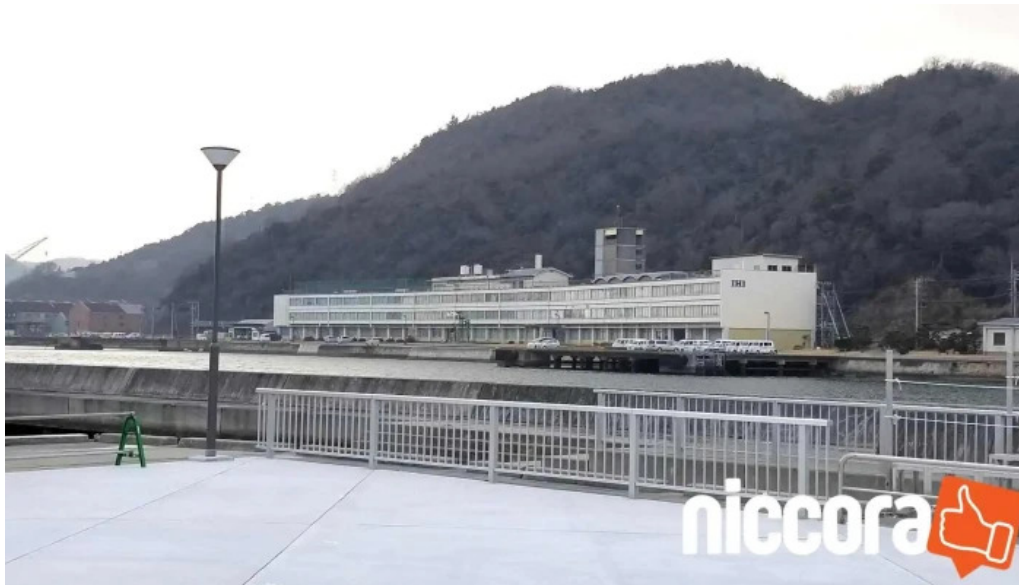
(株)hi汎用ボイラ 相生事業所 相生市
