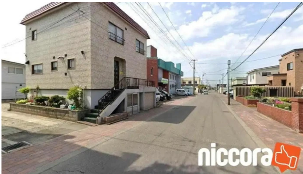
Master repair 岩見沢市
