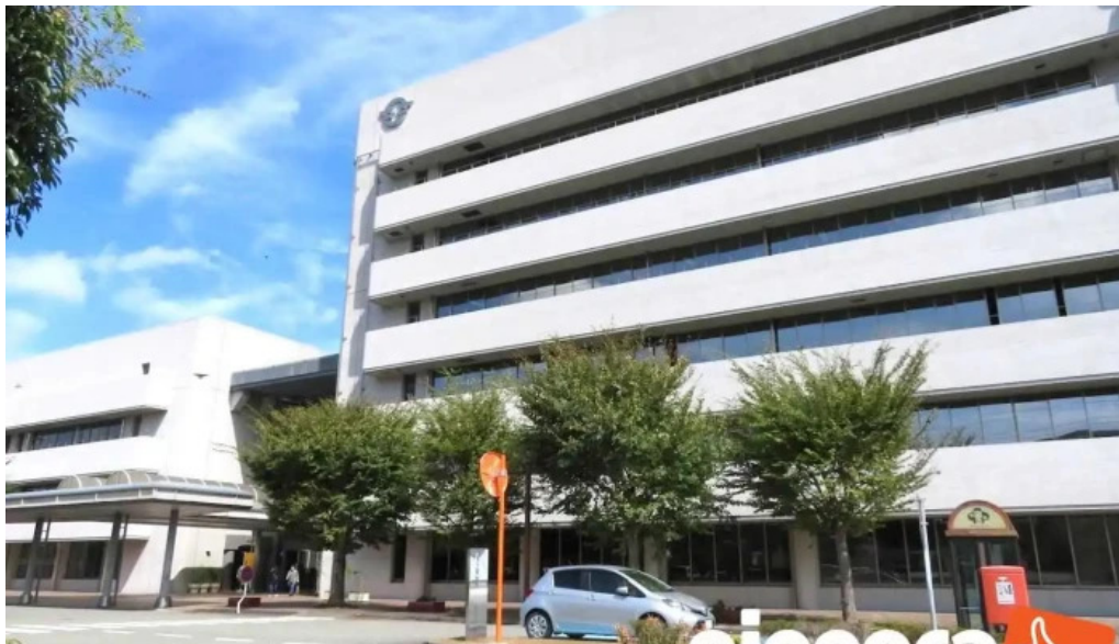
加西市役所 加西市
