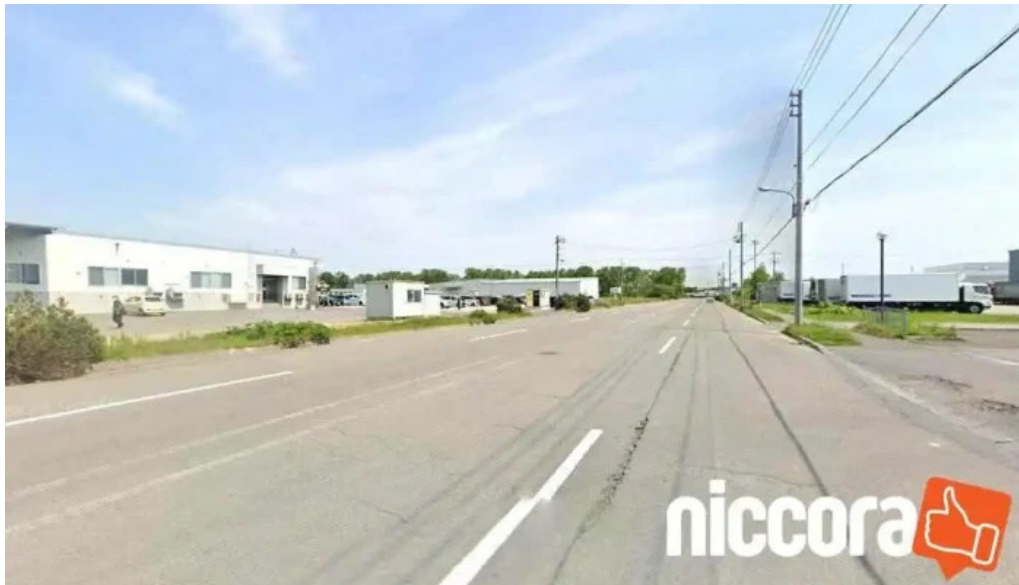
(株)ニチレイ・ロジスティクス北海道 石狩物流センター 石狩市
